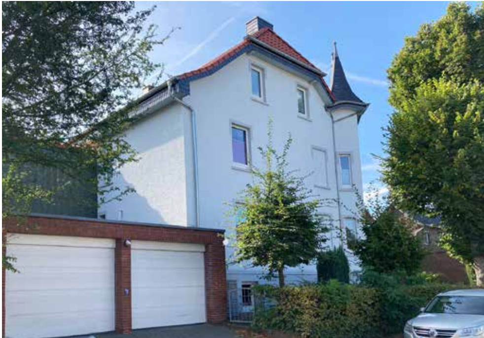
Nordseite des Hauses mit Garageneinfahrten
